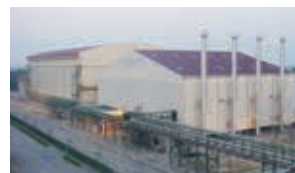
約1か月分 (10,000トン) のもみ殻が貯蔵できる巨大なサイロ (写真奥) とボイラー (手前)
